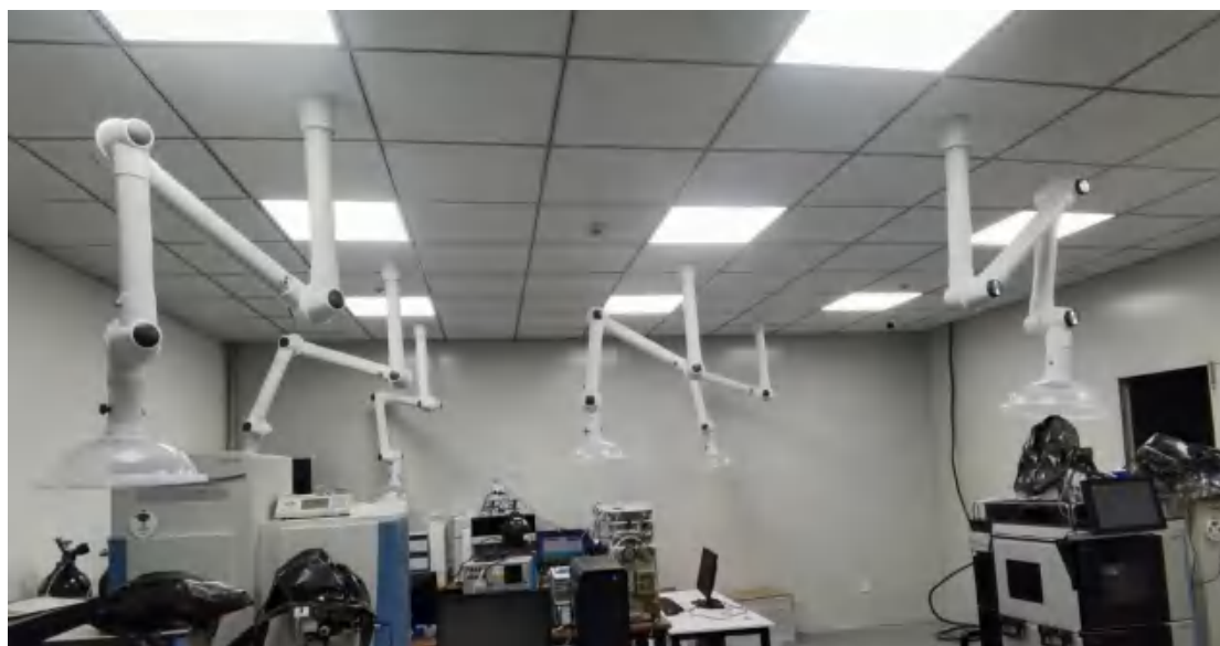
废气收集系统（封闭式实验室+集气罩/通风橱）
