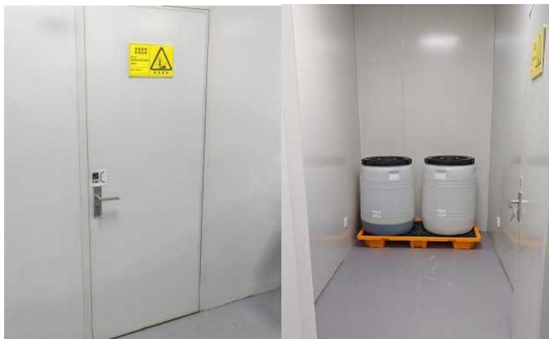
危废仓库（废液收集桶、防渗漏托盘）
