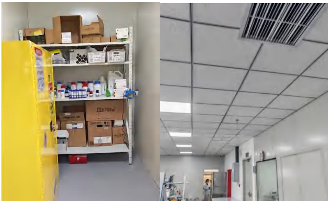
化学品库（可燃气体报警器+防爆柜+消防系统+监控系统）
